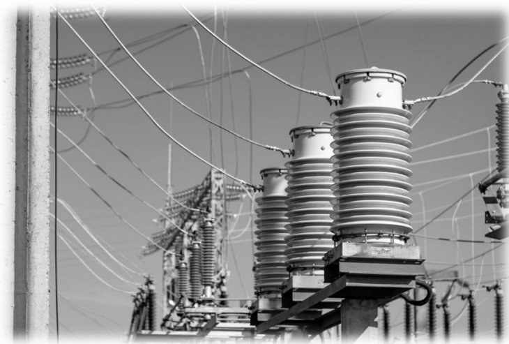
Рис. 1.14. Трансформатор тока типа ТФЗМ-110
