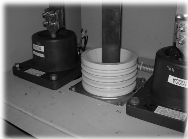
Рис. 1.7. Размещение проходных трансформаторов тока и проходного изолятора в ячейке КРУ
