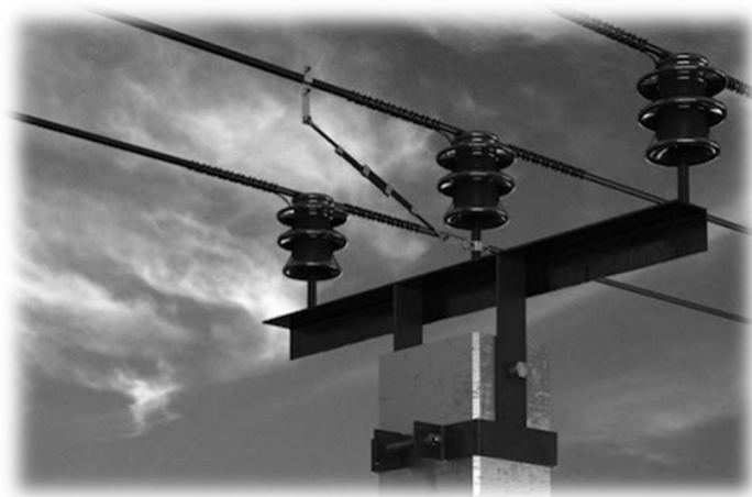
Рис. 1.9. Опорные изоляторы
