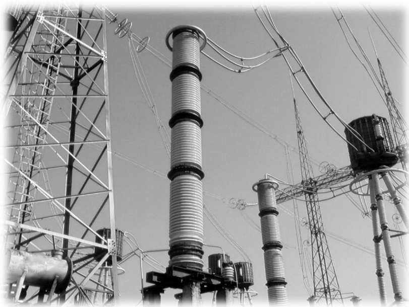
Рис. 1.34. Емкостный делитель напряжения НДЕ-750
