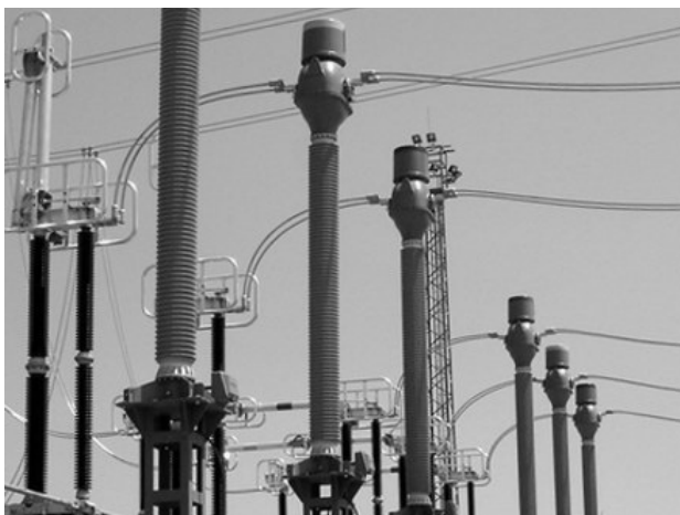
Рис. 1.16. Каскадные трансформаторы тока
