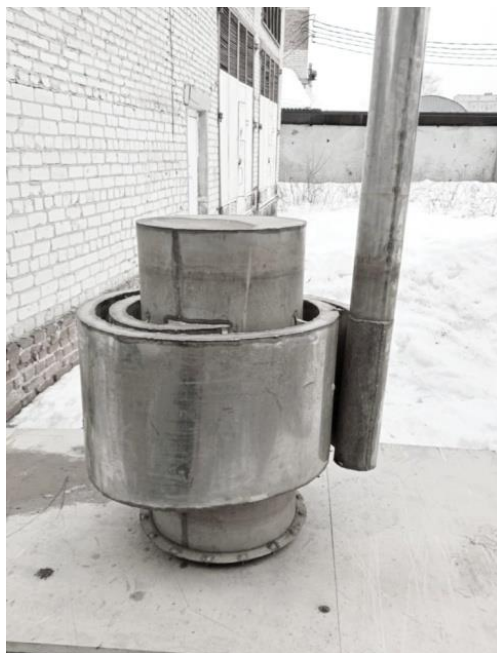
Рис. 2. Общий вид спиралевидного теплообменника
