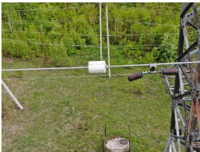
Рис. 2. Новая версия датчик состояния ВЛЭП
