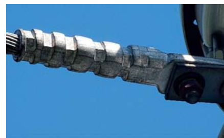
Рис. 7. Аппаратный зажим на ошиновке трансформатора тока ТТ-110 кВ опрессован матрицей для кабельного наконечника
