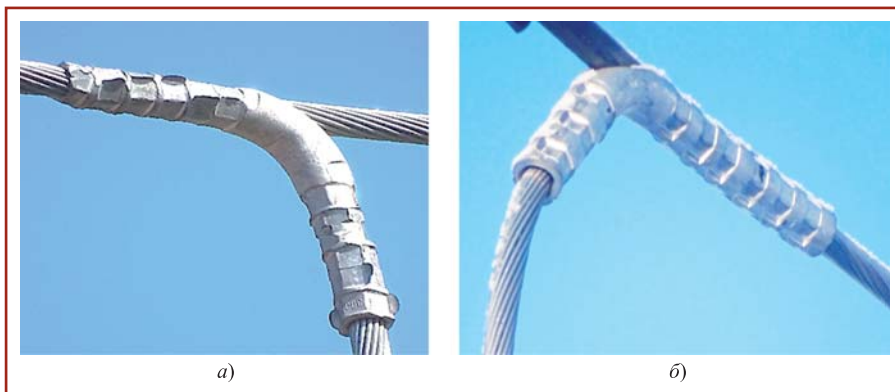
Рис. 5. Ответственный зажим гибкой ошиновки на ОРУ 110 кВ:
