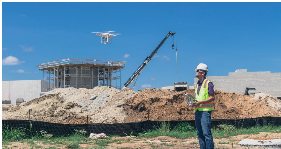
Рис. 1 - Использование БПЛА на строительной площадке
