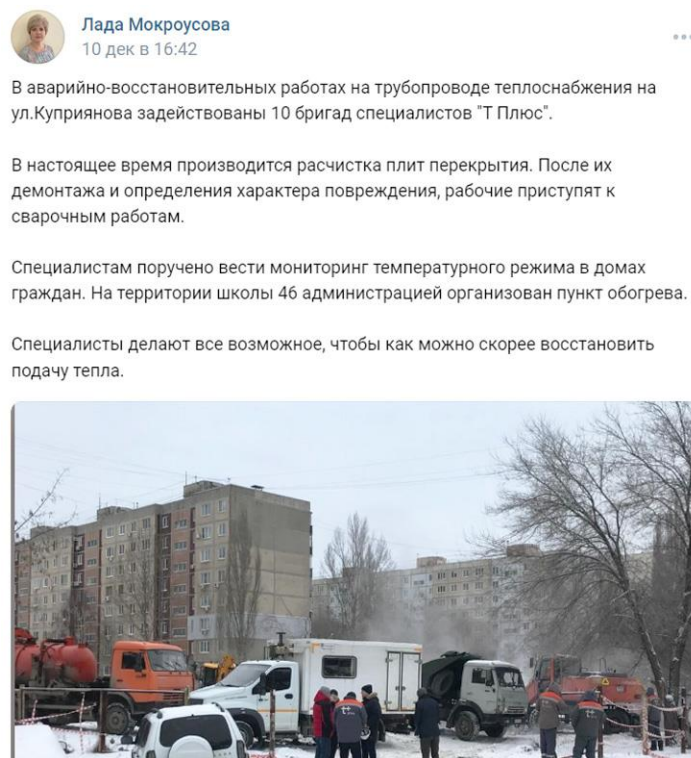
Рис. 1. Пост с информацией о проведении аварийно-восстановительных работ
