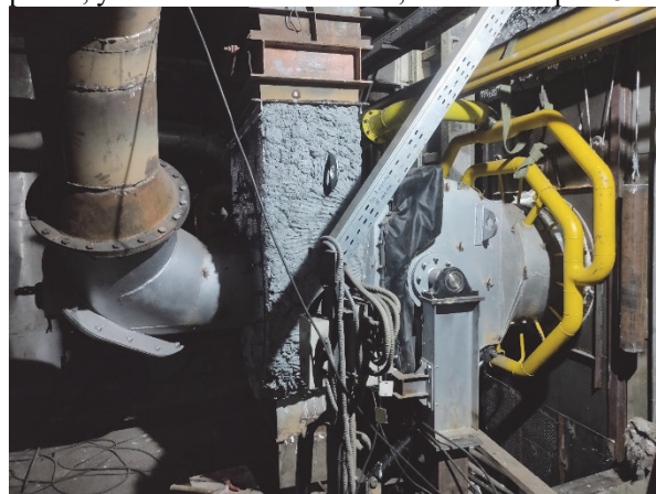
Рис. 5. Головной образец поворотной горелки.
