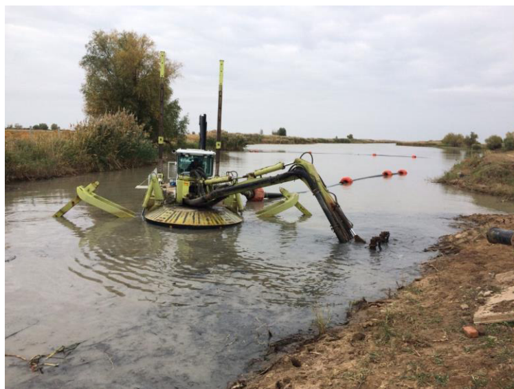
Рис. 2. Очистка русел рек
