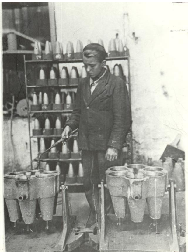
Подготовка форм для отливки корпусов мин
