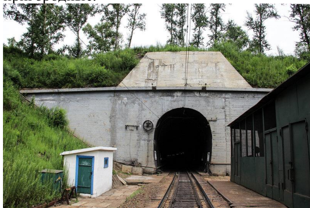
Восточный портал тоннеля, г. Хабаровск
