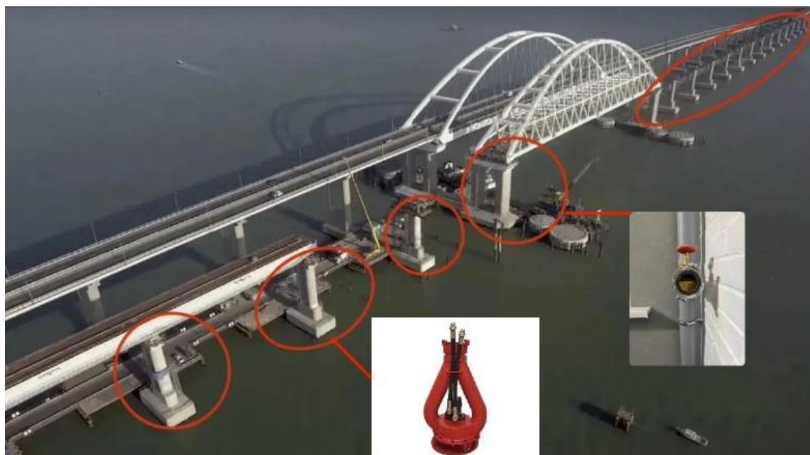
Рис. 1 Места установки стационарных гидравлических насосов и стояков-сухотрубов
